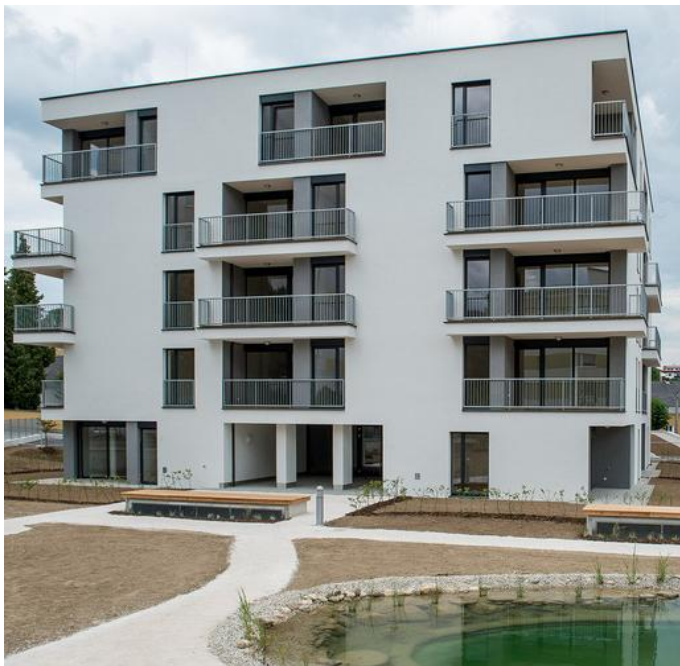
Fotos OÖ Wohnbau
