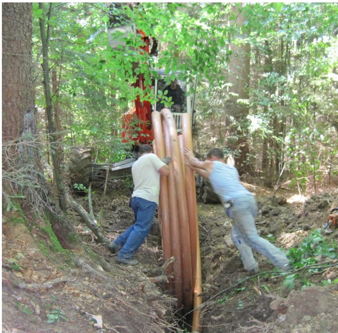
**Kurzbeschreibung:** Der durch eine Hangrutschung beschädigte Ableitungskanal vom Hochleckenhaus der Gemeinde Steinbach am Attersee, wird auf einem Teilstück durch eine PE-RC-Leitung erneuert um die Entsorgung des Alpenverein Schutzhauses wieder sicher zu stellen.
