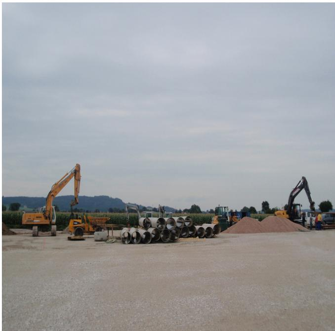
**Kurzbeschreibung:** Im Zuge des Neubaus der Firma Umdasch - Doka iLoc - in St. Georgen im Ybbsfelde ist eine Entsorgung der Schmutz- und Reinwässer, so wie eine Versorgung mit einer Wasserleitung zu errichten. In den Reinwasserkanal sind eine Vielzahl von Straßeneinläufen einzubinden und schließlich in ein bauseits errichtetes STB-Retentionsbecken abzuleiten.
